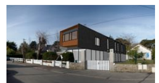
Maison O, La Baule 2010
