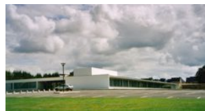
Groupe Scolaire de Ploumagoar, Ploumagoar 2001
